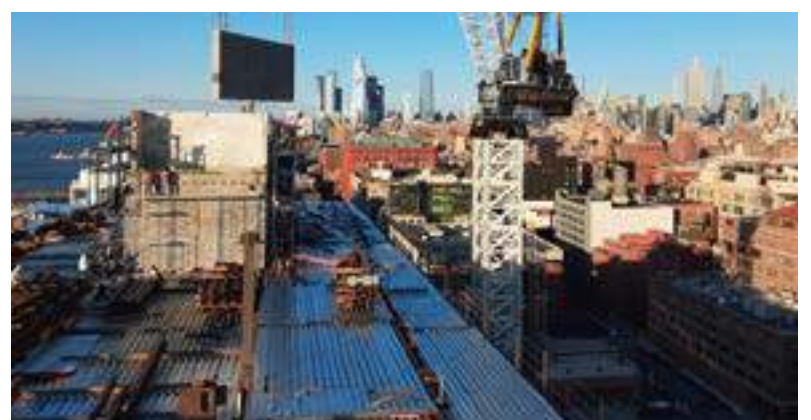
Figura 11. Completamento in quota di un "core"
