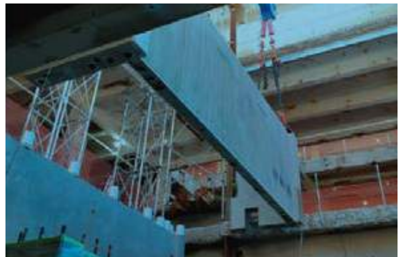
Figura 10. Fase di posizionamento di un concio
