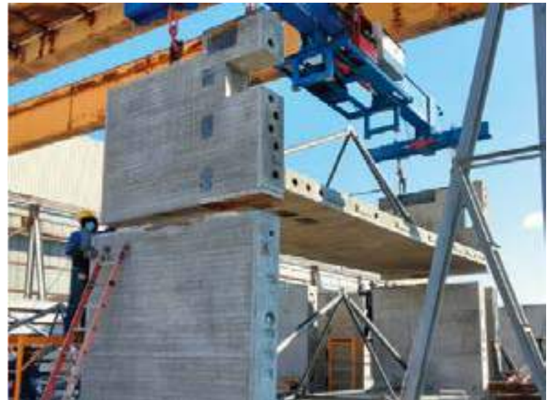
Figura 9. Posizionamento dei conci nell'area di stoccaggio
