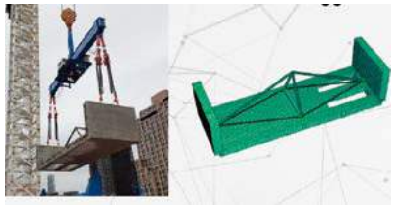
Figura 7. Fase di movimentazione di un concio
